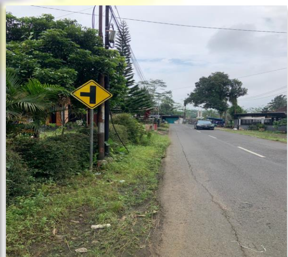
Pemasangan rambu lalu lintas
