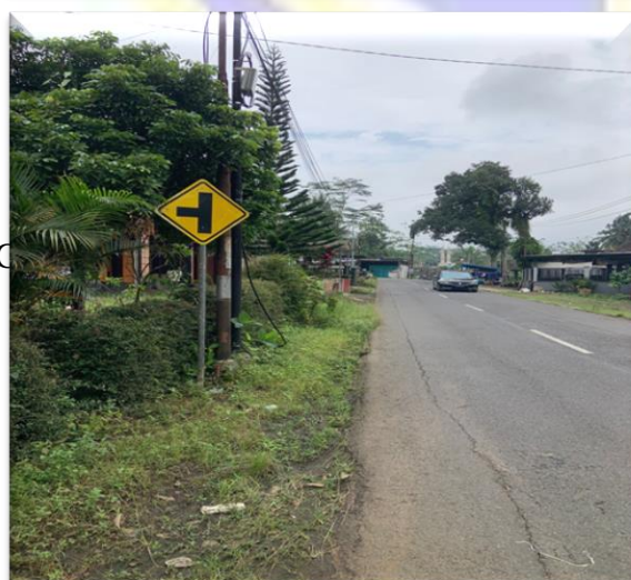
Pemasangan rambu lalu lintas
